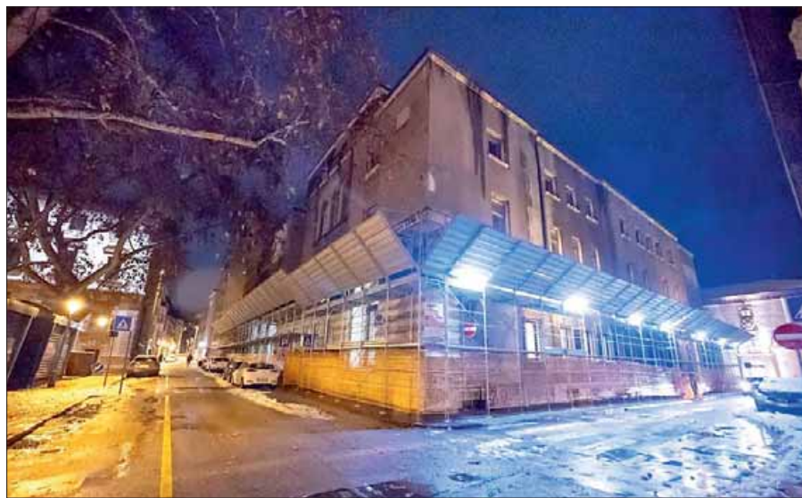
Le impalcature all'esterno del palazzo delle Poste
