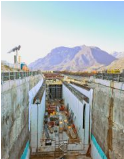
Bypass Il cantiere di Mattarello
